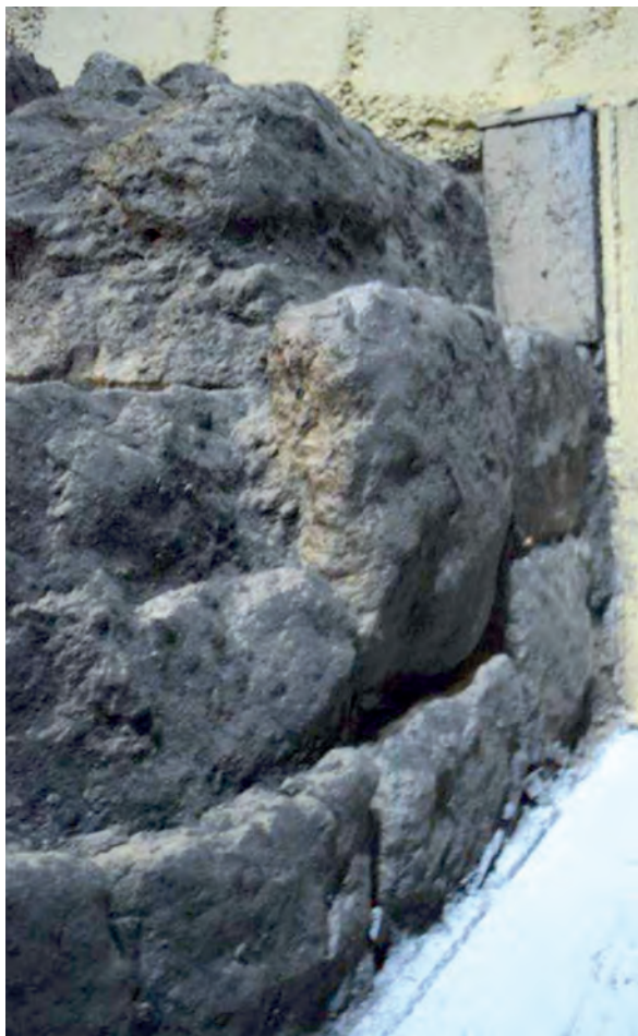
Fig. 5: Preparación a base de sillares cuadrangulares para la instalación de la muralla islámica.
